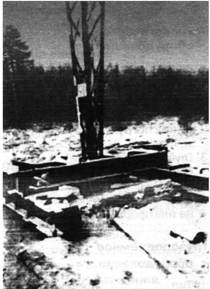
Рис.3. Фундамент на винтовых сваях для опоры ПОМ-220.
